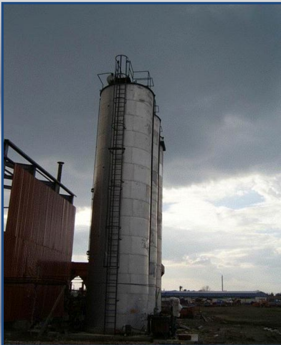
Silos za bitumen
